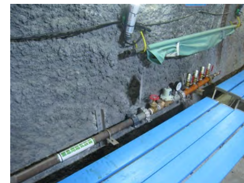
緊急用給気設備 (地上から空気を導入できます)
